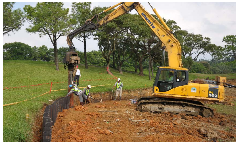
步驟八：以打樁機依所需深度打入土層
