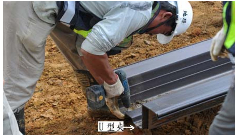
步驟四：底部以 U 型夾固定
