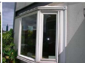
塑鋼窗現場實測
